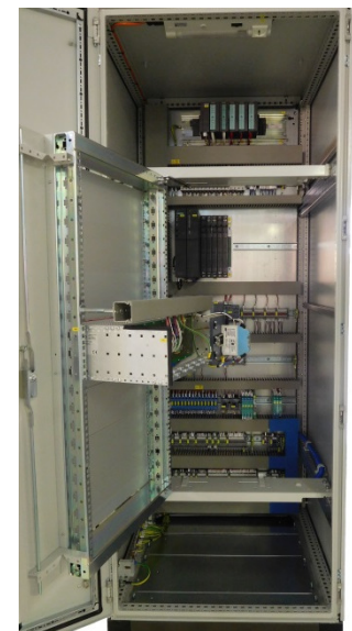
Abbildung links: Reaktorregler mit geöffneter Schranktür
