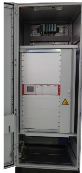
Abbildung links: Reaktorregler mit geöffneter Schranktür
