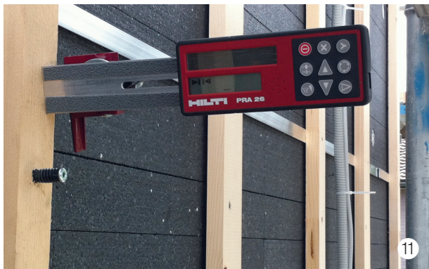
Alignement des lattes, p.e. avec un laser rotatif.
