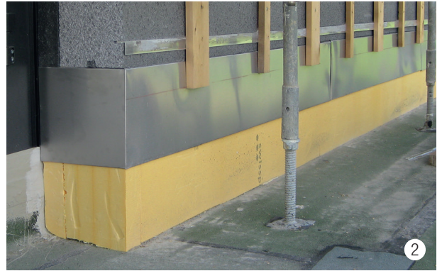
Pied de la façade avec une isolation de socle swissporXPS et un revêtement de tôle.
