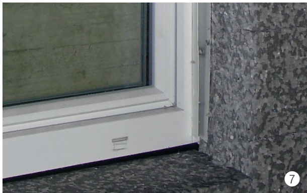
Préparation des embrasures avec un Profil-F.
