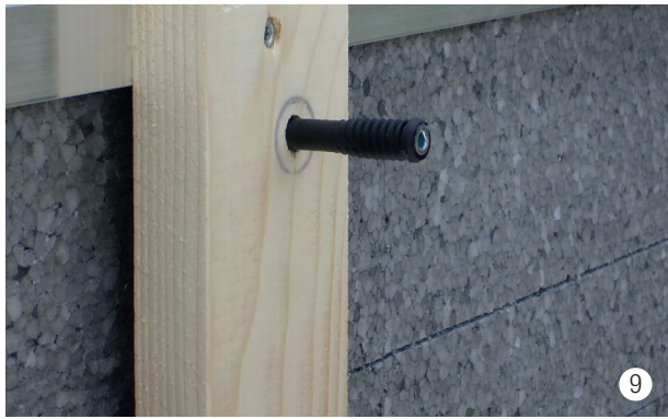
La vis de fixation de sécurité est insérée dans le trou.
