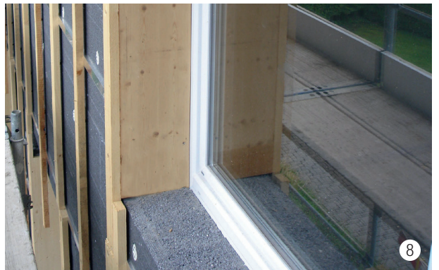
Finition des embrasures avec lame en bois massif.
