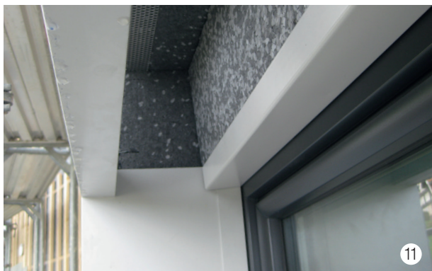
Isolation des caissons de store.
