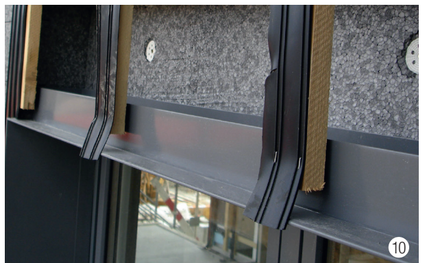
Linteau de fenêtre en métal.
