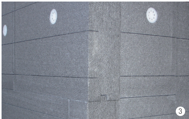
Finition des angles sortants.
