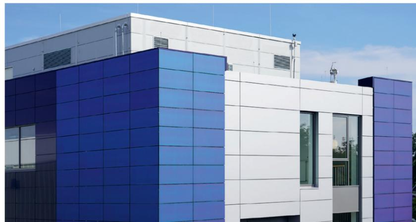
ren. Die Produktplattform ist einzigartig in punkto Design, Energieeffizienz, Leistung, Qualität und Produktsicherheit – und als einziges Modul seiner Art zugelassen für Fassaden mit Windlasten bis zu 100 Meter Höhe.
