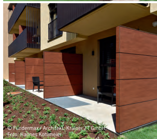
© Fundermax / Architekt: Krainer ZT GmbH Foto: Hannes Kohlmeier
