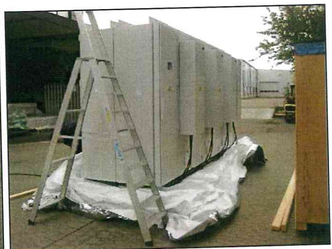
Aufsetzen der Schaltschränke
