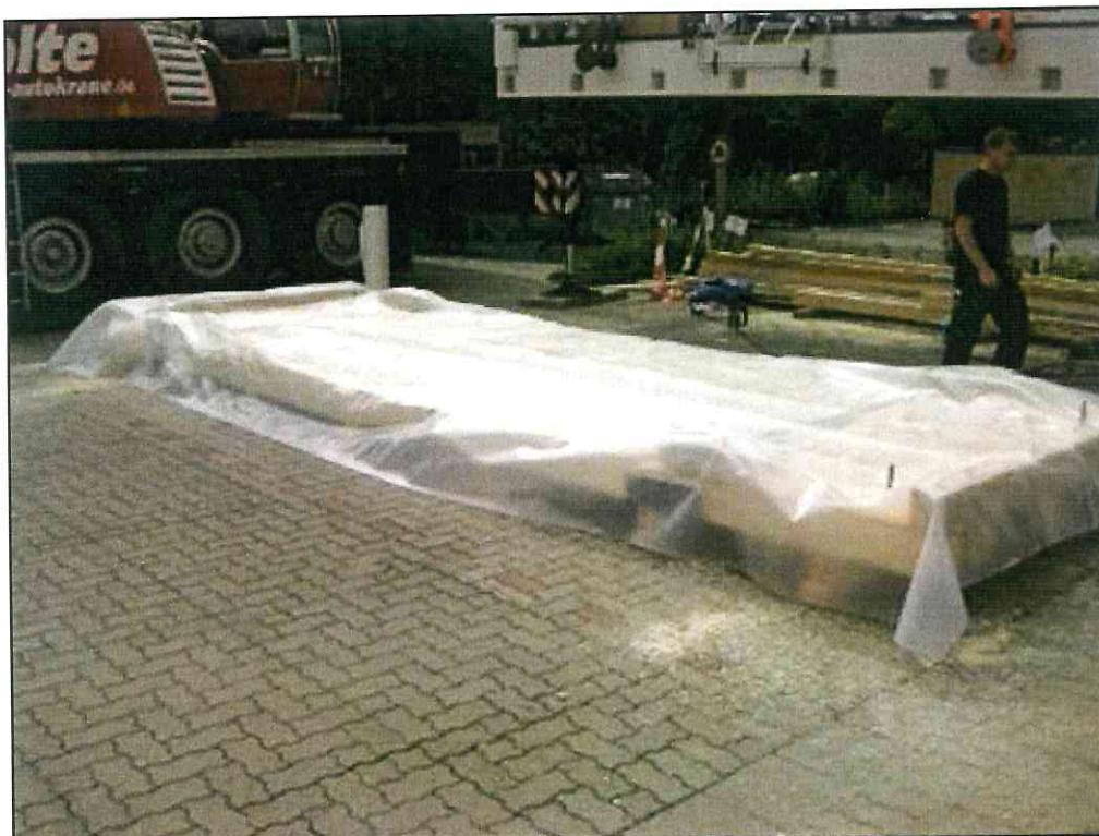
Auslegen des Bodens mit PE-Folie
