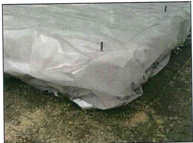
Auslegen des Bodens mit PE-Folie
