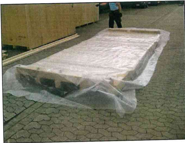
Auslegen des Bodens mit PE-Folie
