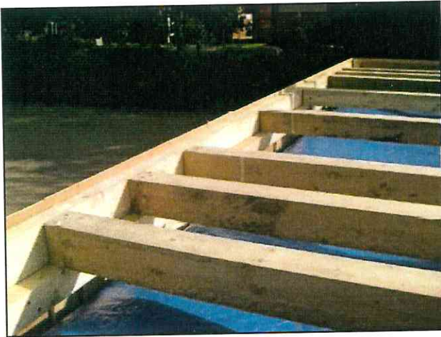
Einsetzen der Deckelunterzüge (Kantholz 12 cm x 14 cm)
