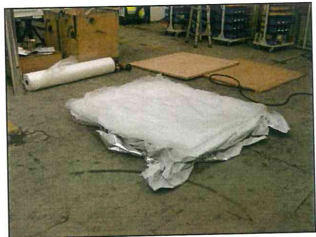
Auslegen des Bodens mit Schaumfolie
