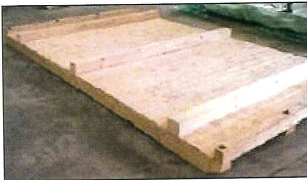
Bereitstellen der Plattform mit aufgelegten Lagerhölzern
