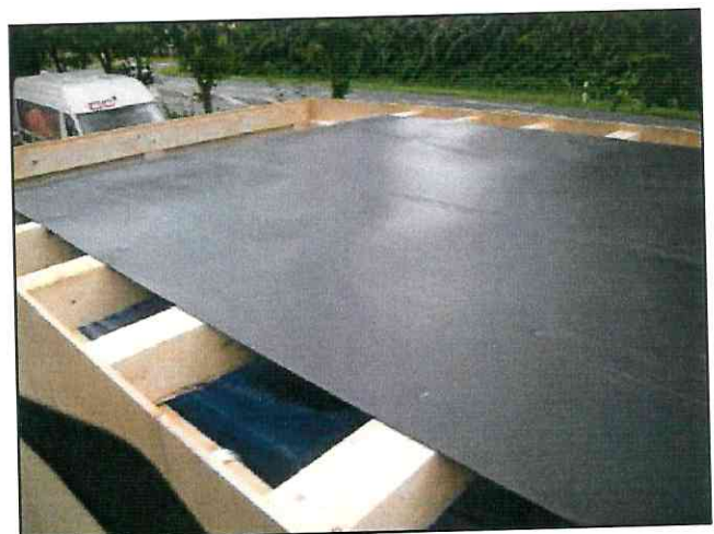
Auflegen von Akyluxplatten auf die Deckhölzer
