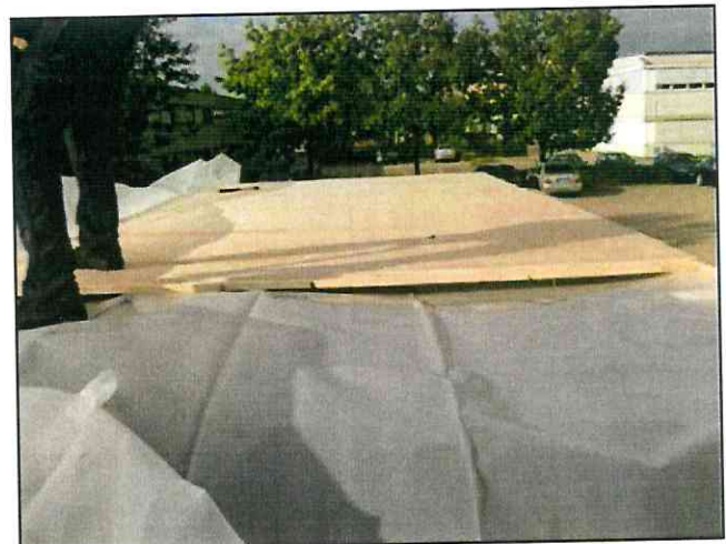
Aufsetzen des aus Fertigungsgründen dreiteiligen Deckels
