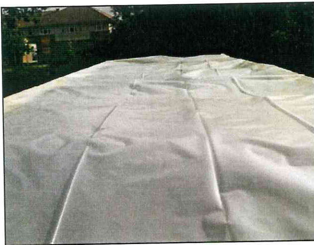
Auflegen einer durchgängigen PE-Folie auf die Akyluxplatten
