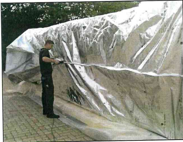
Aufsetzen der Aluminiumverbund-Folienhaube und verschweißen mit der Bodenfolie
