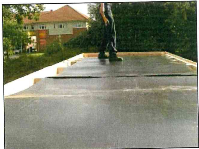
Auflegen von Akyluxplatten auf die Deckelunterzüge
