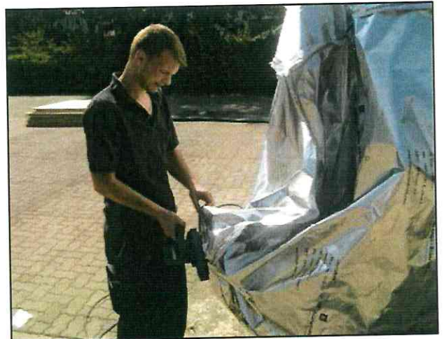
Absaugen der Luft zwecks Dichtheitskontrolle mit anschließendem Versiegeln der Absaugöffnung
