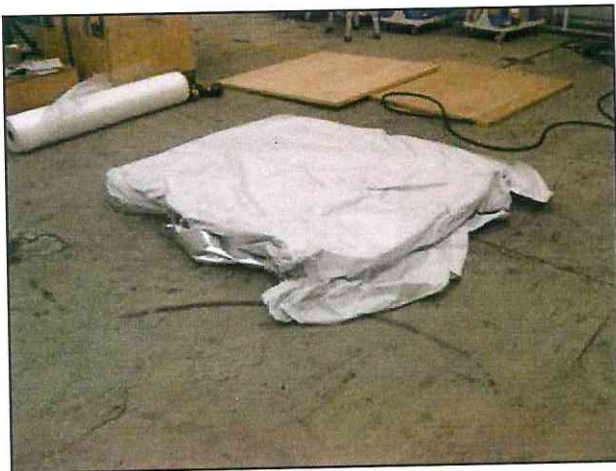
Auslegen des Bodens mit Aluminiumverbund-Folie
