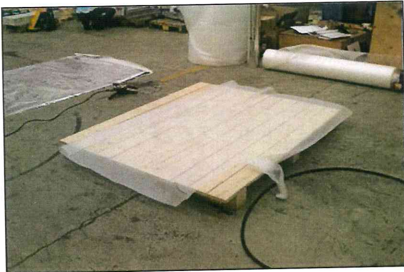
Auslegen des Bodens mit Schaumfolie
