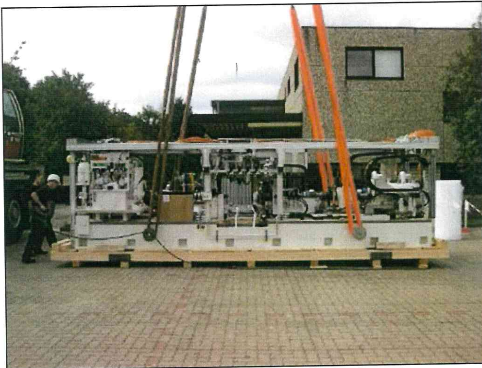
Aufsetzen des Prüfstandes auf den Boden zwecks Markierung der Bohrungen für die Befestigungsbolzen
