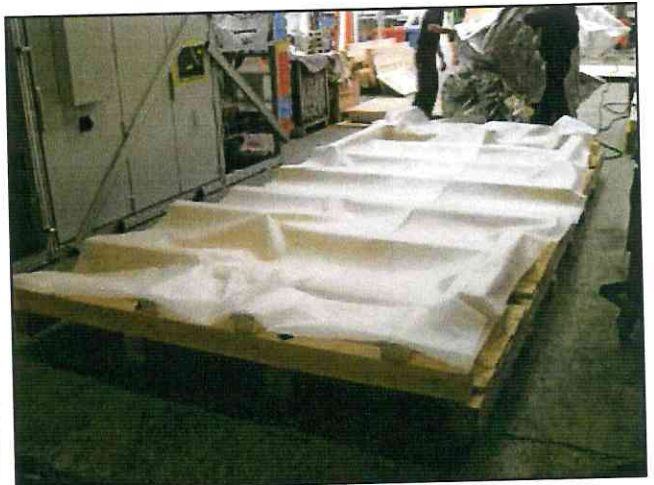
Auslegen des Bodens mit Schaumfolie
