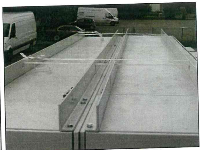
Befestigung der Schränke untereinander mit Polyester-Spannband (Cordstrap 2000 dN)
