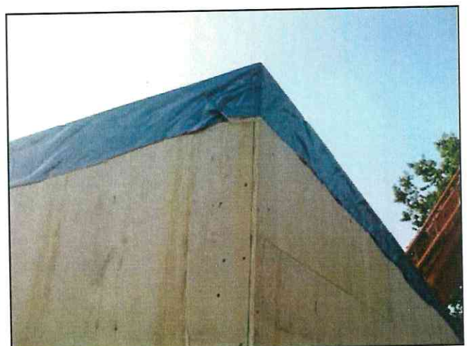
Anbringung einer Kopfhaube aus Gewebeplane
