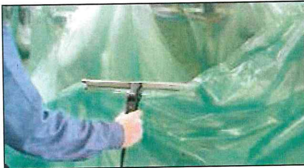
Nach dem Auflegen wird die Folie verschweißt. (Eine Öffnung für das Absaugen der Luft freilassen!)
