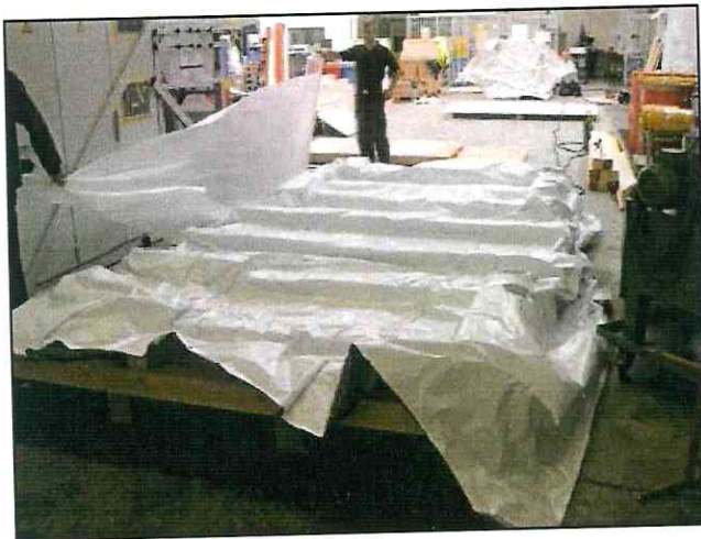
Auslegen des Bodens mit Aluminiumverbund-Folie
