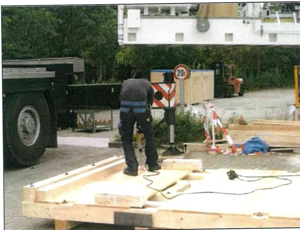
Einbringen der Bohrungen
