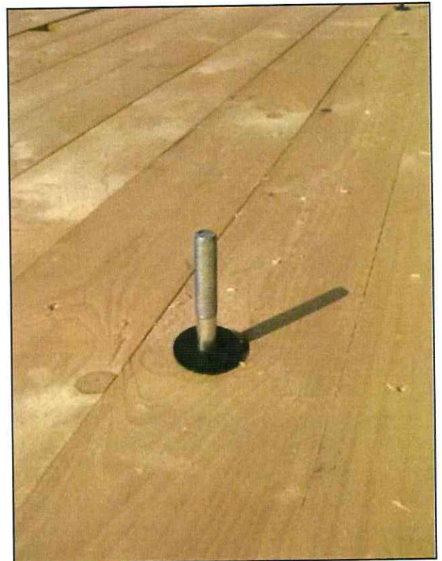
Aufsetzen von Gummidichtringen auf die Bolzen
