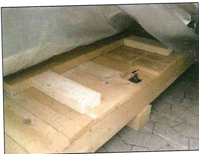
Seitliche Anbringung von Kanthölzern außerhalb der Sperrschichthülle gegen Vershub
