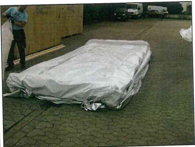
Auslegen des Bodens mit Aluminiumverbund-Folie
