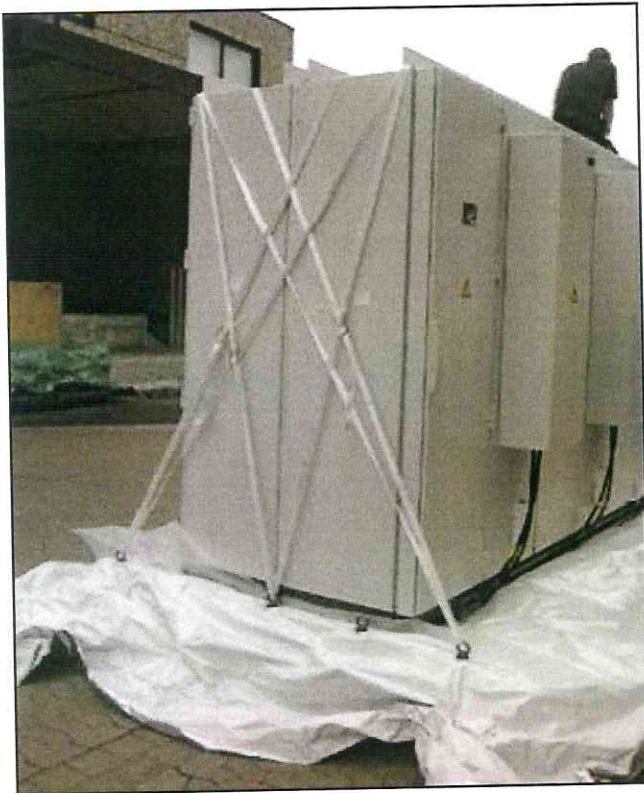
Fixieren der Schränke auf dem Kistenboden durch Polyester-Spannband (Cordstrap 2000 dN)
