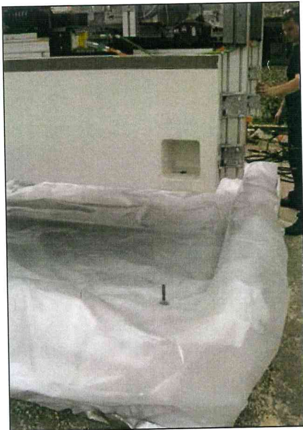
Aufsetzen der Maschine auf die Bolzen
