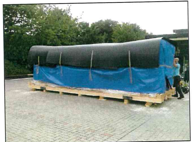
Auflegen von Akyluxplatten
