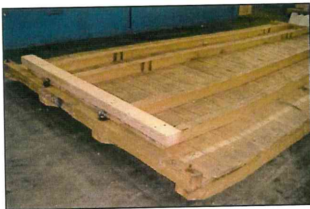
Bereitstellen der Plattform mit aufgelegten Lagerhölzern und Begrenzungsholz
