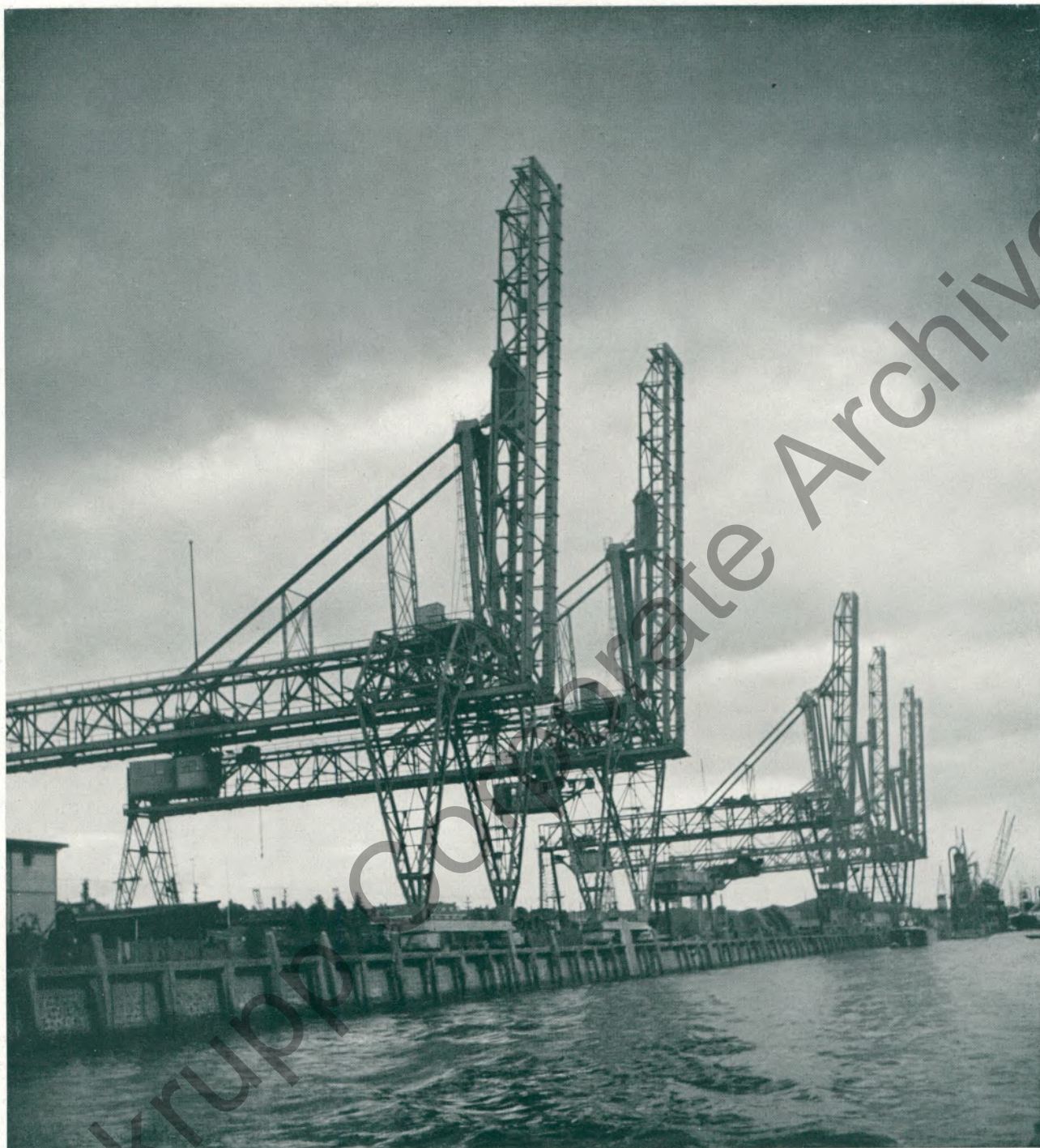
Entladebrücken für überseeische Erze im Rotterdamer Hafen.
