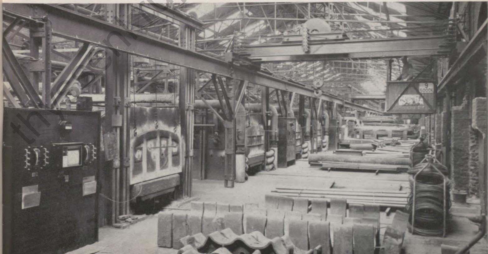
kehrt er schon in schlanker Gestalt zurück. Doch wieder wird er gefaßt, um seinen glühenden Leib in die folgende engere Öffnung zu zwingen. So geht es mehreremale, und jedesmal kommt er dünner und länger zum Vorschein. Zuletzt ist aus dem dicken Block ein langer Stab geworden.
