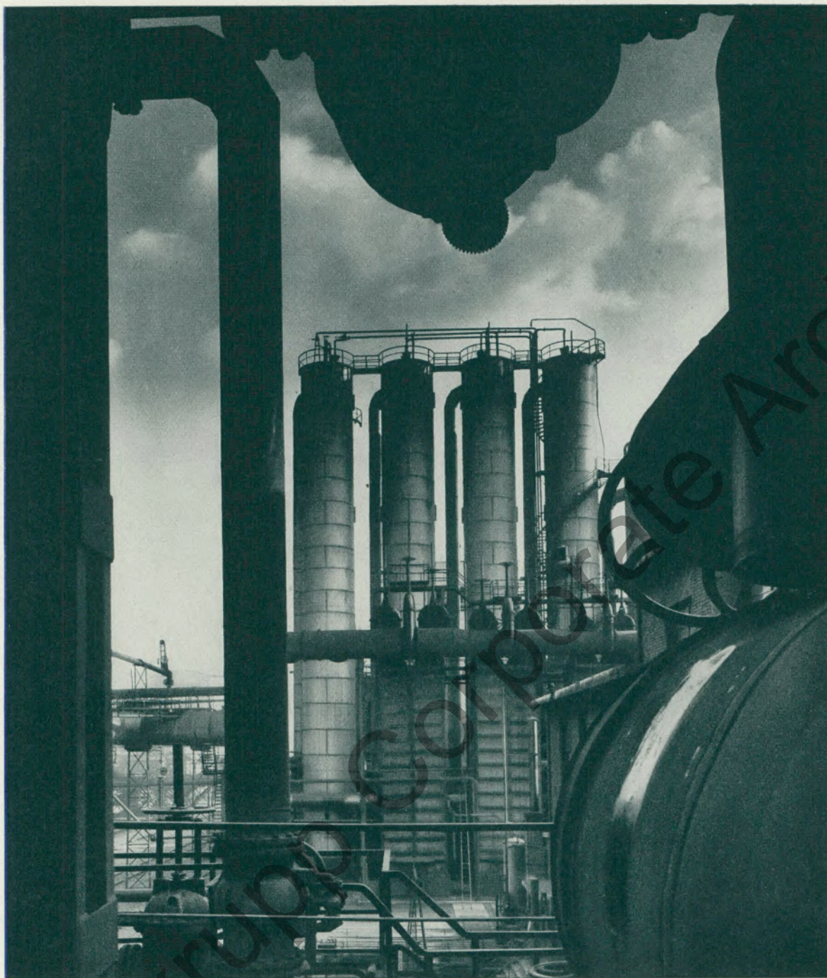
Gasfühler und Benzolwascher der Zeche „Minister Stein“. (Gruppe Dortmund der Gelsenkirchener Bergwerks- A.G.)
