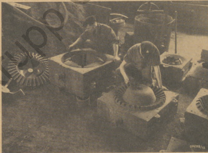
Das Einformen von Regelrädern erfordert geschickte Hände
