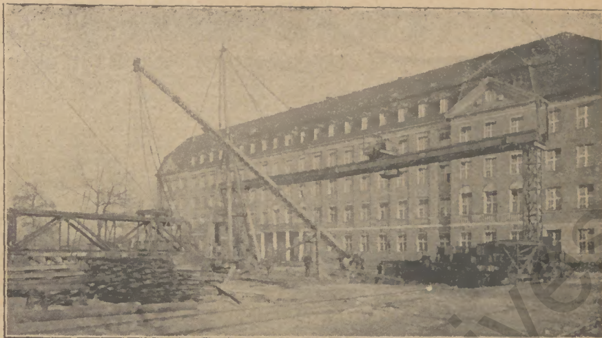
Hochrichten der rechten Hilfsstütze (11. 11. 26).
