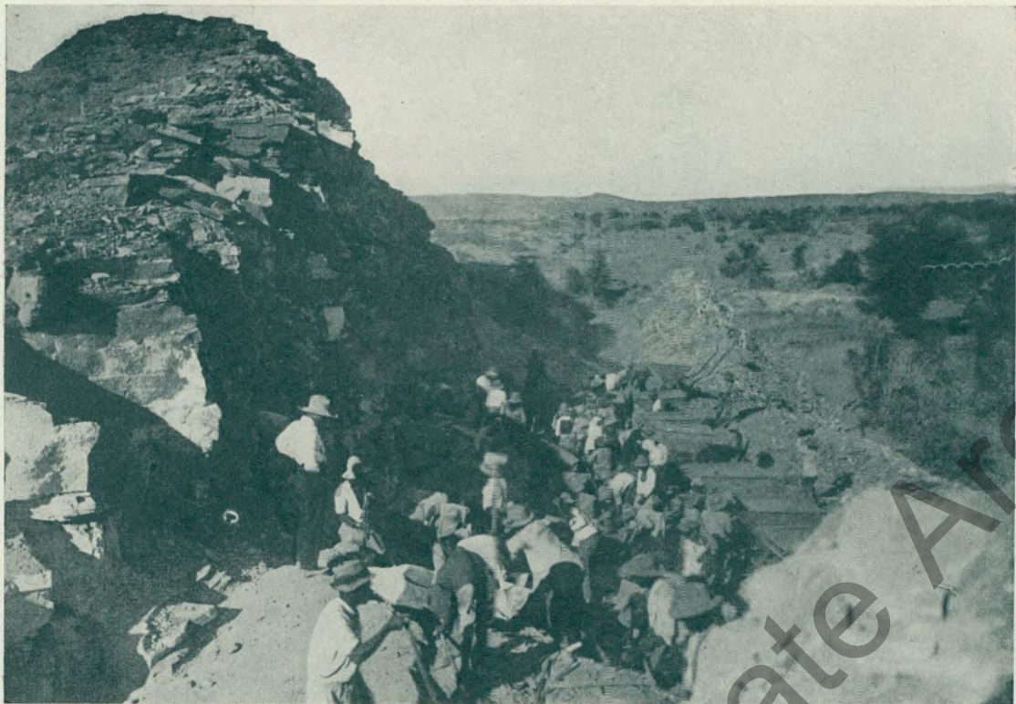
Eisenbahn- bau in der Nähe der Lüderitzbucht.
