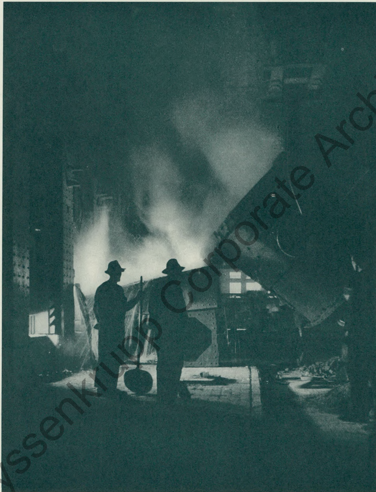
Roheiseneinguß im Siemens-Martin-Stahlwerk der „Bochumer Verein für Gußstahlfabrikation A.-G.“, Bochum.
