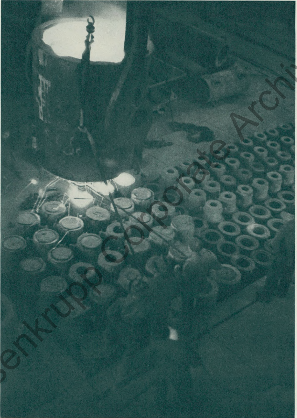
Rotillenguß im Elektro Stahlwerk der „Bochumer Verein für Gußstahlfabrikation A.-G.“, Bochum.
