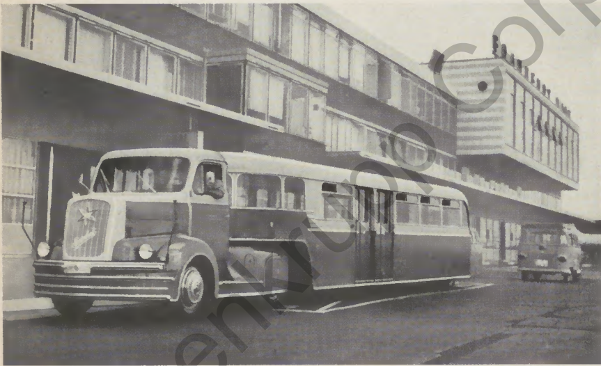
HS 95 S in Sonderausführung mit Omnibusaufleger für den Flugfeldverkehr. Besondere Wendigkeit und hohes Anzugsvermögen gewährleisten einen ausgezeichneten Zubringerdienst.
