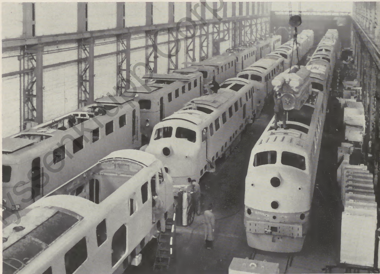
Blick in die Montage-Straße der diesel-elektrischen Lokomotiven AA 16
