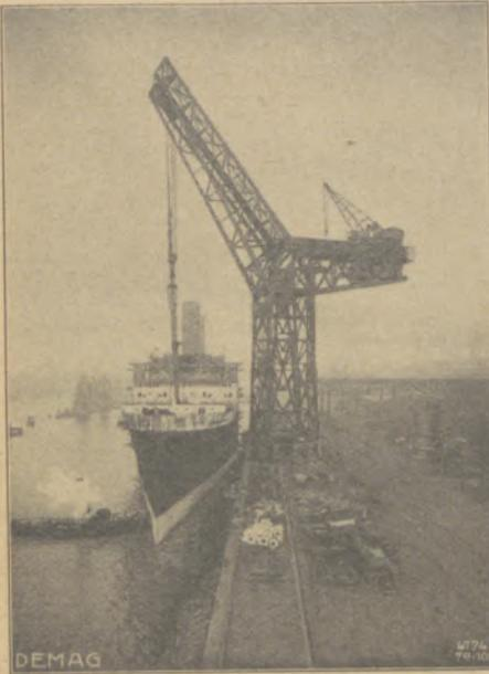
Der erste Riesen-Hammerkran mit wippbarem Ausleger, erbaut im Jahre 1913 als größter Kran der Welt, Tragkraft 250 Tonnen bei 34,5 Meter Ausladung, 110 Tonnen bei 53 Meter Ausladung und 10 Tonnen bei 73,5 Meter Ausladung
