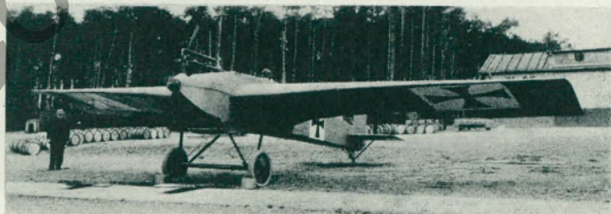
„Junkers J 1“. Das erste Ganzmetallflugzeug der Welt (Baujahr 1915). (Bildbild: Archiv der Junkers Flugzeug- und Motorenwerke, Dessau).
