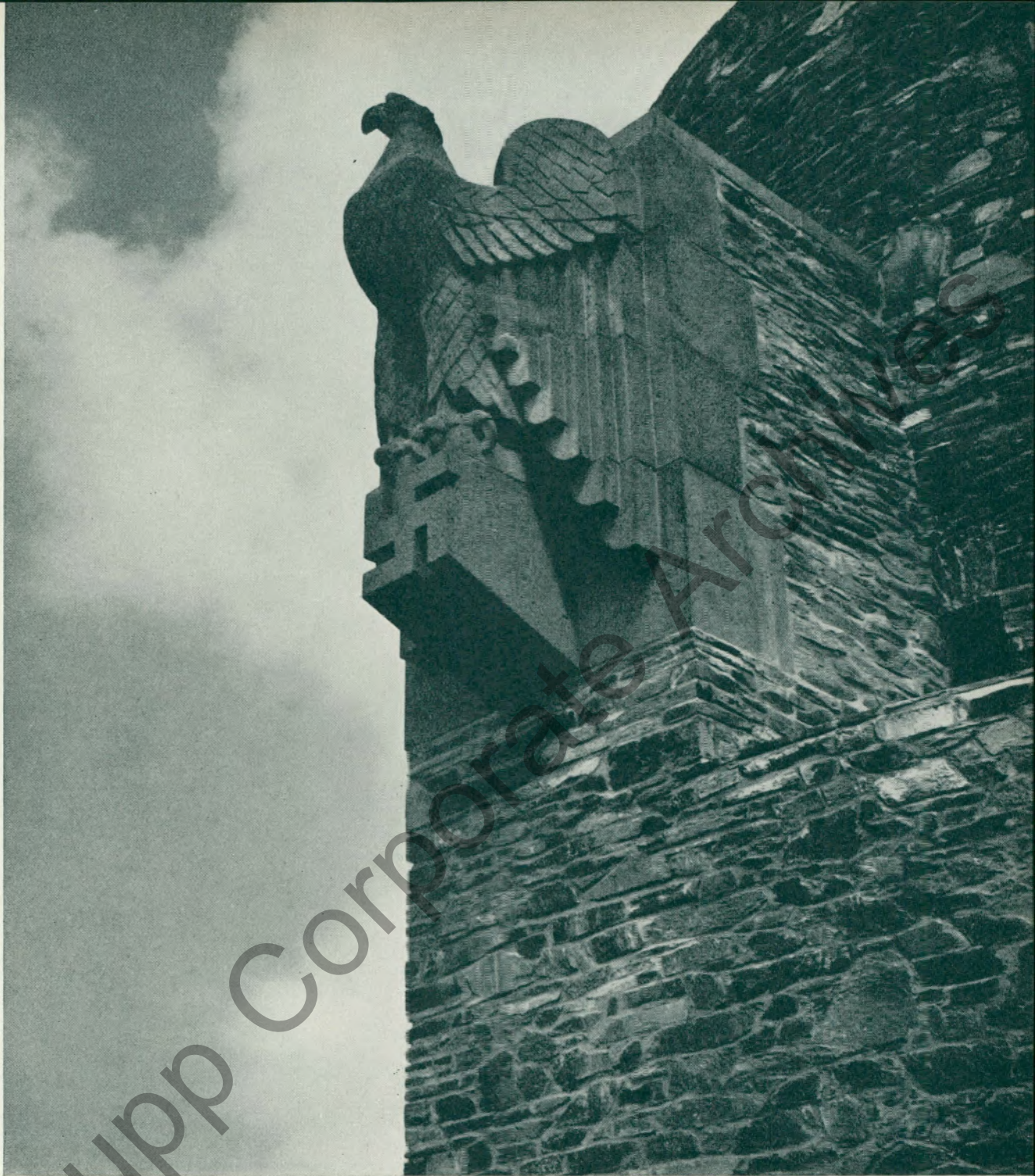
Turm der neuen Thingstätte auf der Lorelei.
