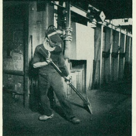
Am Platinenwärme- ofen.
