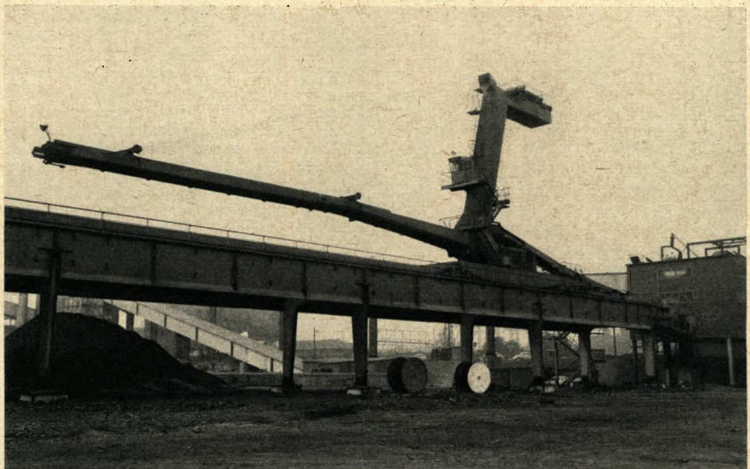
► Mit diesem modernen Schwenkabsetzer, einer Neuentwicklung mit 33 Metern Auslegerlänge, wird das Erz ausgelagert. Um eine Staubbildung zu vermeiden, kann er auf Schütthöhe eingestellt und fast bis auf die Lagersohle abgesenkt werden
