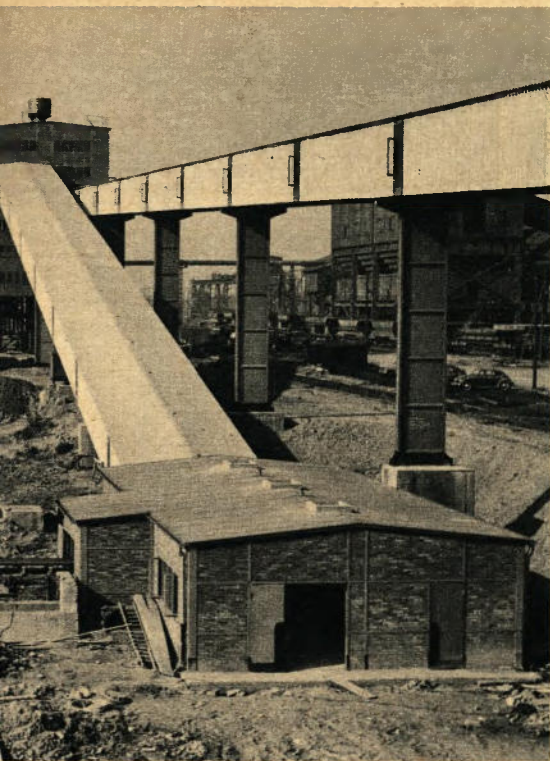
▲ Ein weiträumiges Transportbandsystem zieht sich durch die ganze Anlage. Um die Luft möglichst rein zu halten, sind die Bänder entweder in geschlossene Brücken verlegt oder mit Windleitwänden versehen
