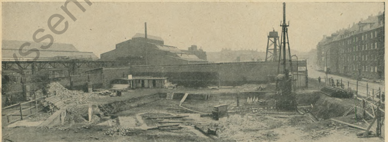
Aussichten der Baugrube unterhalb der Spundwandunterkante
