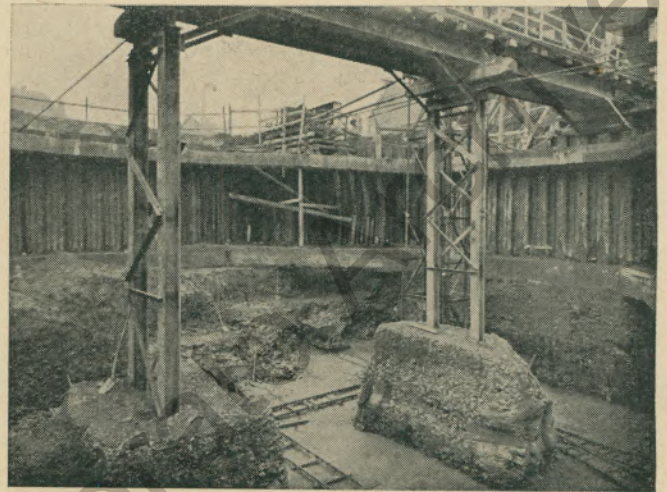
Rammen der Stahlpundwände in vorbereiteter Baugrube
