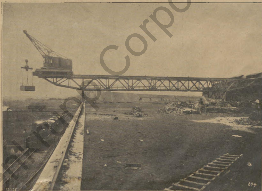
Rohschlackenhalbe und Kranbrücke der Thomasmühle der Abt. Ruhrort.
