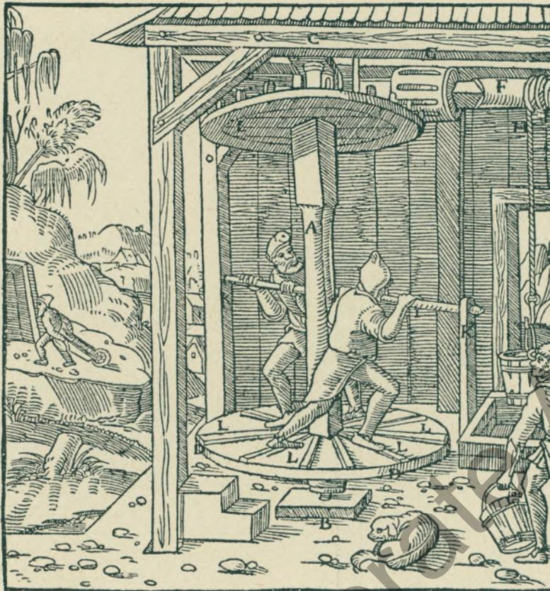
baum war das Förderseil gewickelt und befestigt. An den Seilenden hingen eiserne Haken, in welche die Fördergefäße eingehängt wurden. Den Antrieb besorgten drei Arbeiter. Zwei standen links am Kreuz, einer rechts an der Kurbel. Zur Erleichterung der Drehbewegung besaß der Rundbaum ein Schwungrad, dessen Speichen mit Blei beschwert wurden. Trotzdem blieb diese Förderarbeit eine körperlich schwere Tätigkeit (Abb. 2).
