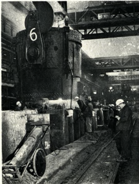
Eine 160-Tonnen-Pfanne im SM-Werk I wird abgegossen. — Rechts: Im SM-Werk II werden Schmiedeblocke gegossen. — Bild Mitte: Der Stahlübergabewagen transportiert die Pfanne in die Gießhalle von SM II
