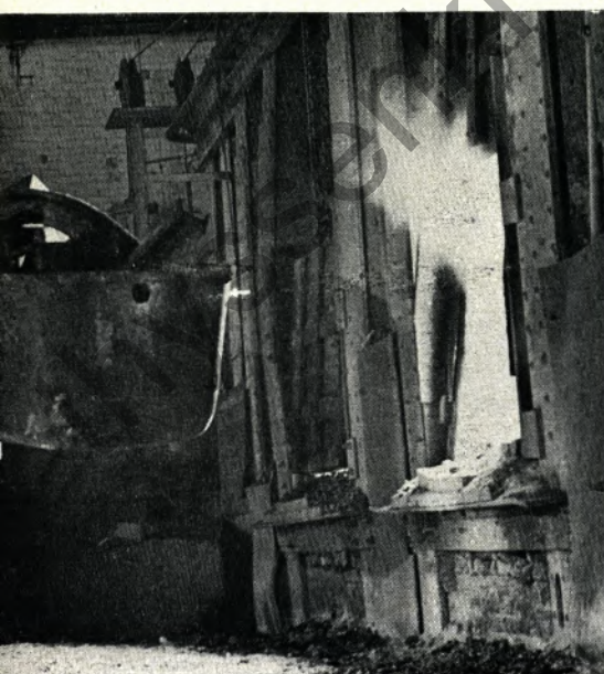
zer Geske. — Unten: Der Ofen 1 im SM-Werk II wird von einem Chargierkran mit Schrott beschickt. — Bild rechts: Das ist nicht etwa ein Feuerwerk, sondern der Abstich eines 80-Tonnen-Ofens im SM-Werk II
