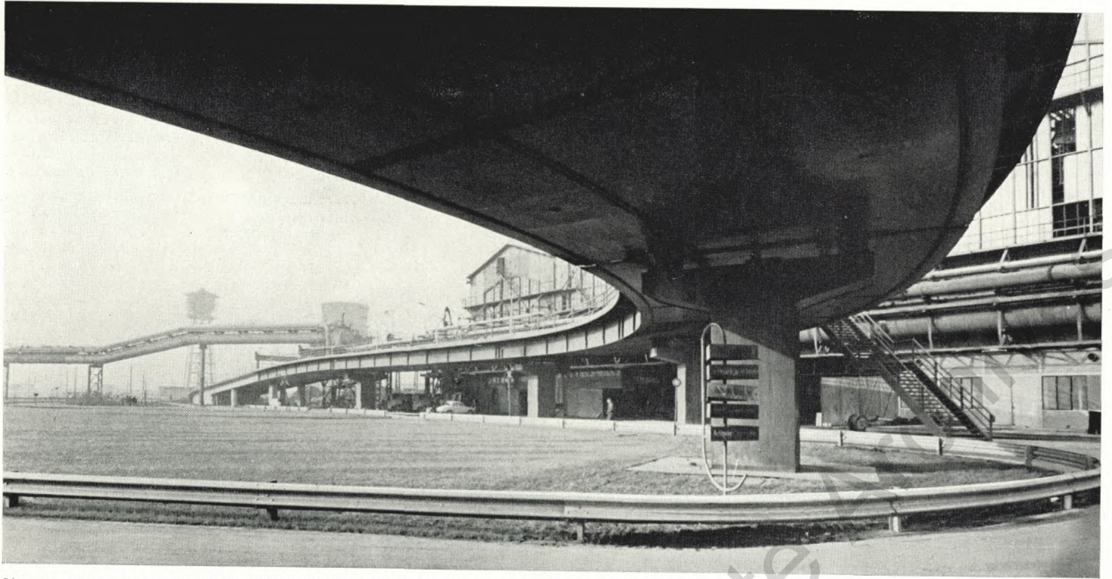
Die neue Hochstraße erleichtert den innerbetrieblichen Verkehr zwischen Warmbreitbandwerk und SM-Stahlwerk II
