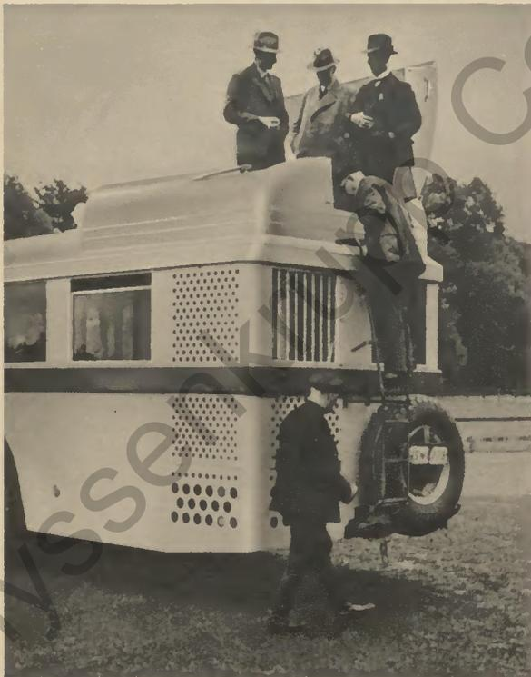
Rückansicht einer in einen Omnibus eingebauten verkleideten Generatoranlage mit Holzvorratsraum auf dem Dach
