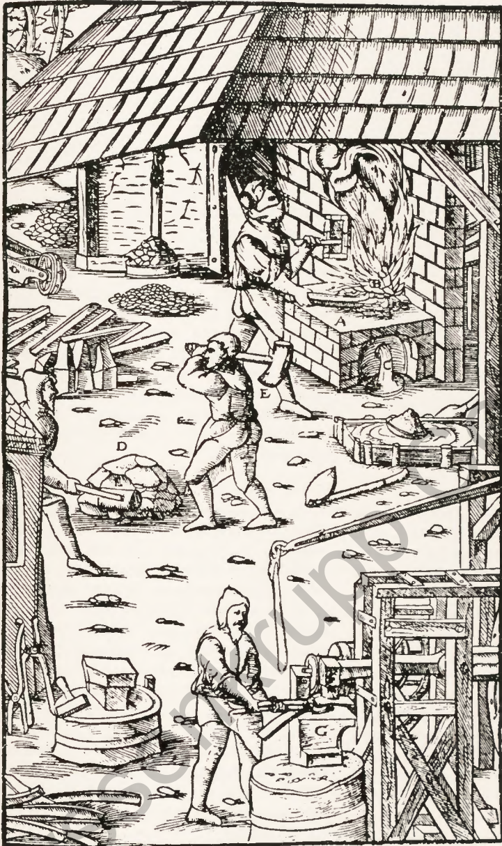
Rennfeuer (Aus Agricola: De re metallica)
