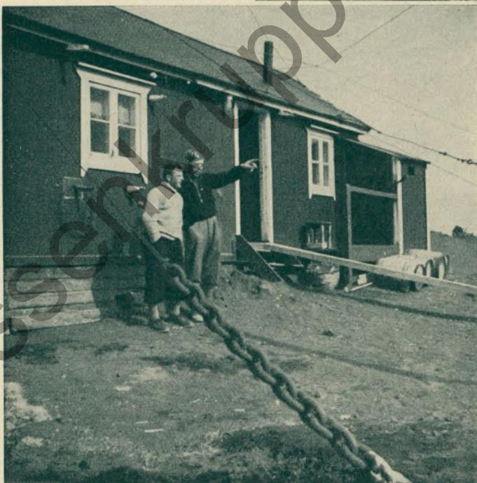
Mit schweren Ketten und Stahldrahtseilen sind die Gebäude der Station gegen die rasenden Drakane gesichert
