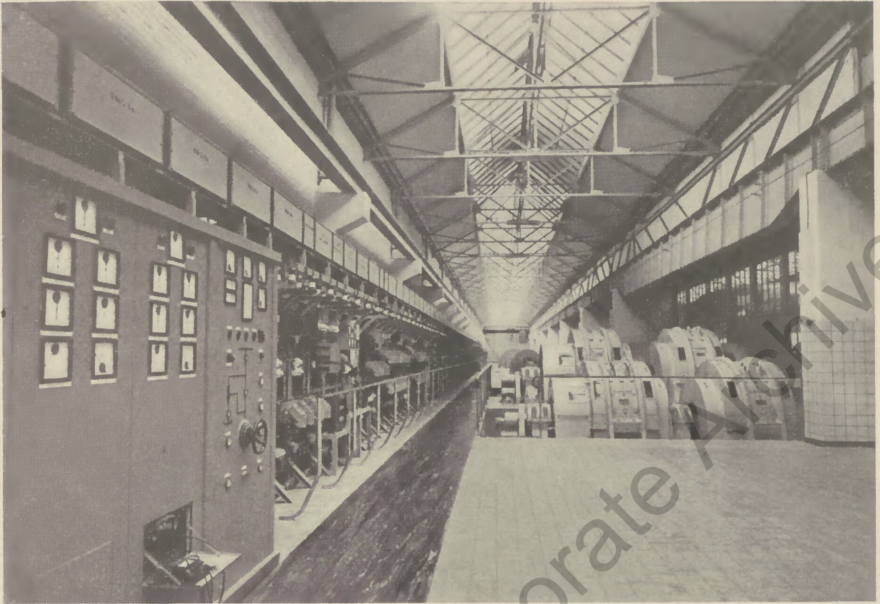
Abb. 2 Maschinenhalle für die Reversiergerüste I und II
