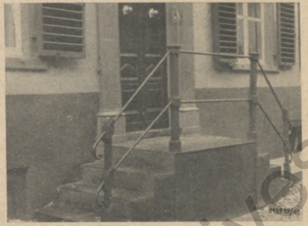
Bild 10: Gußeiserne Treppe vor dem Hause Nr. 3 in der Schloßstraße in Anholt
