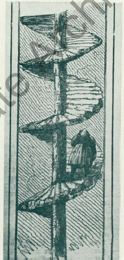
Enge steile Wendeltreppen verbinden die einzelnen Sohlen miteinander. Die Kohle wird hier in Körben transportiert.
