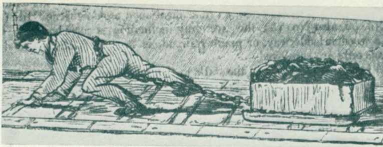
Zwölfjähriger Knabe beim Schleppen eines auf Rufen gleitenden Kohlschlittens. Er zieht die Last an einer Kette, die um seinen Leib geschlungen ist, hinter sich her. Auf der Lederkappe ein offenes (!) Licht.
