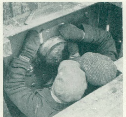
Wieder einmal ist der Brückenbogen um vierzehn Zentimeter gehoben. Der Bolzen wird (oberes Bild) aus der Kette herausgezogen und (unteres Bild) ein Loch tiefer gesteckt.
