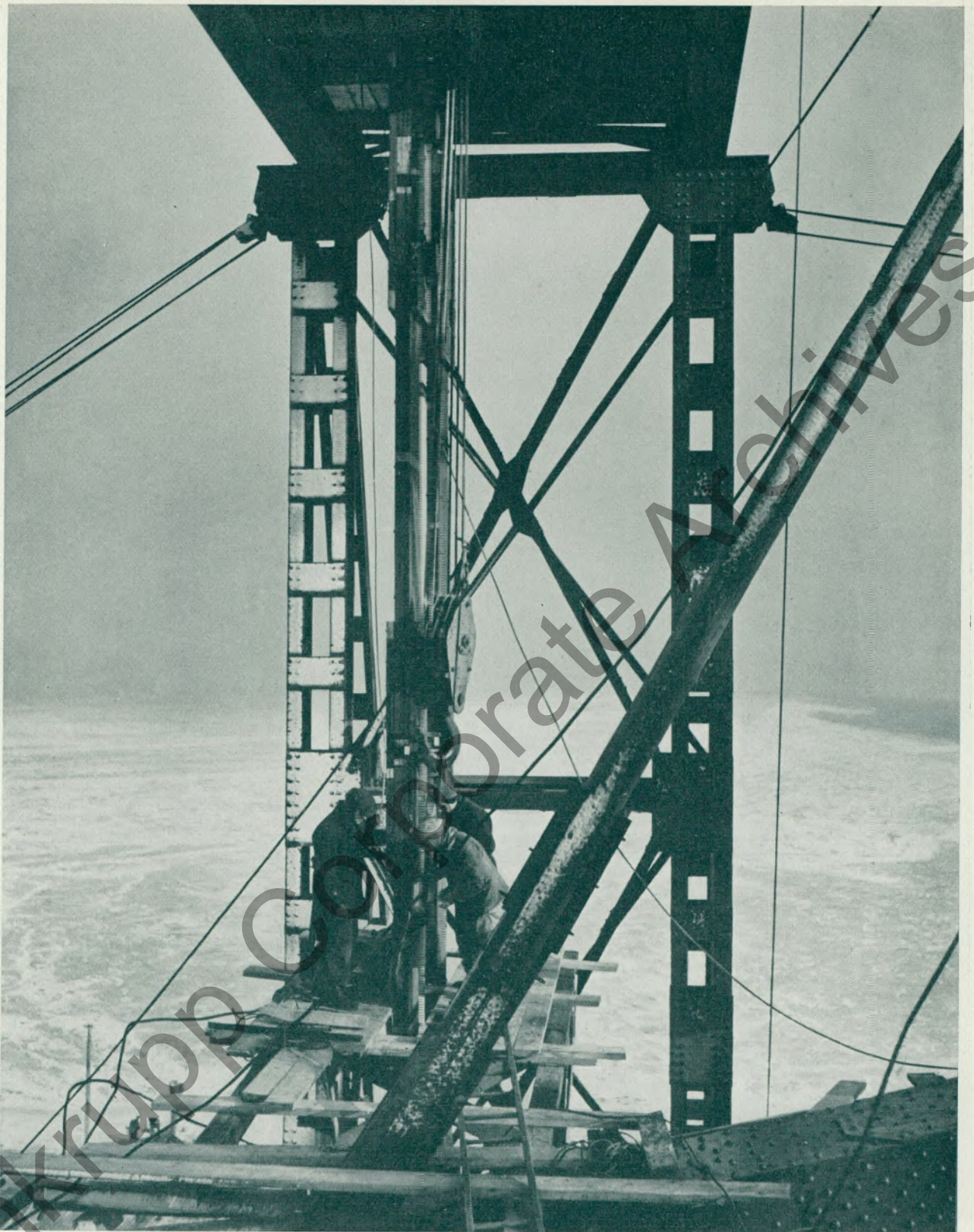
Beim Einhängen einer der Ketten unter der Hubtraverse.
