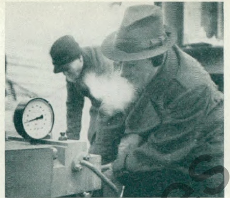
Mit aufmerksamem Blick verfolgt Inspektor F. den Zeiger des Manometers an der Motorpumpe, der ihm die Stärke des Wasserdruckes anzeigt . . .
