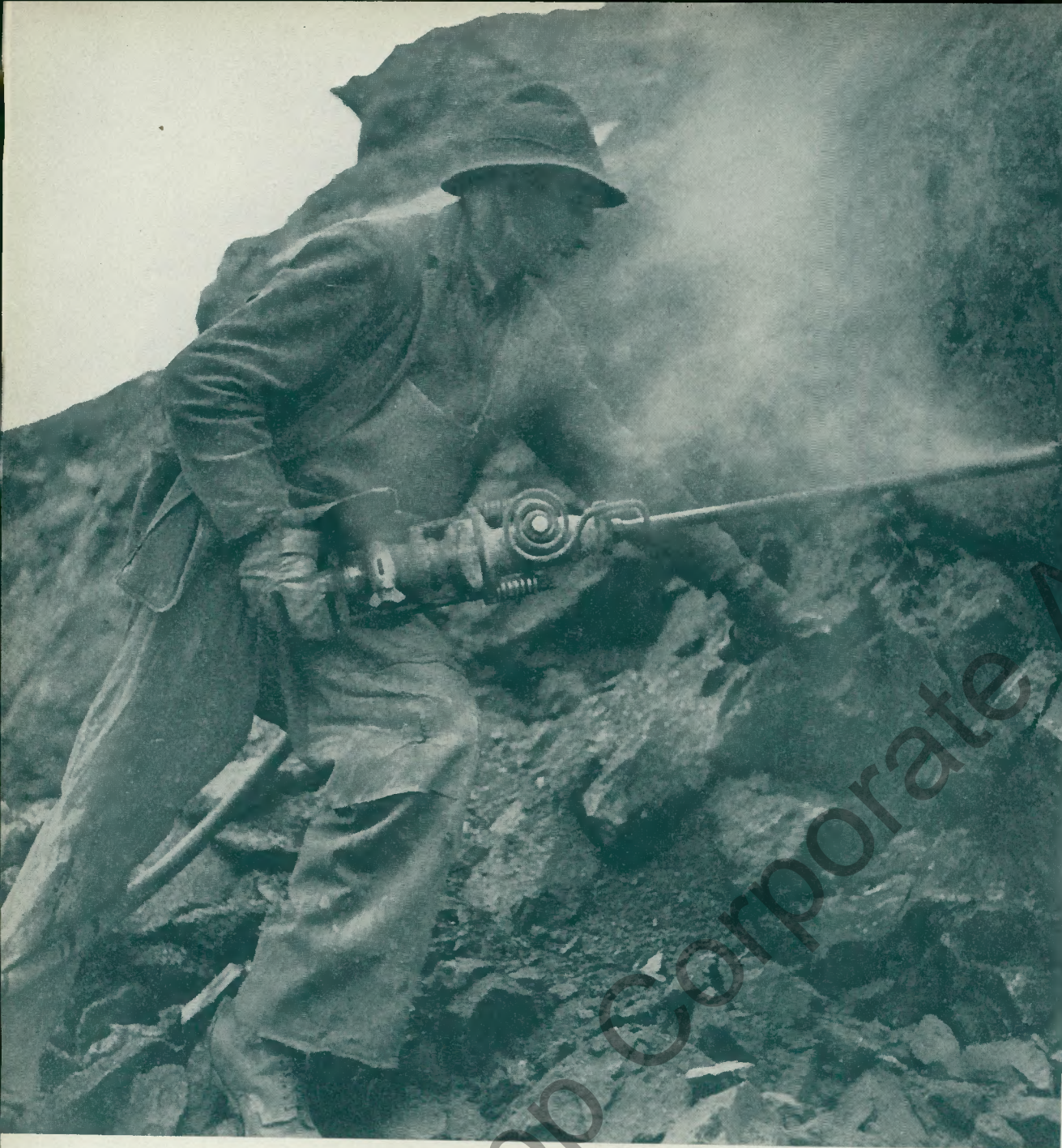
Beim Bohren von Sprenglöchern.
