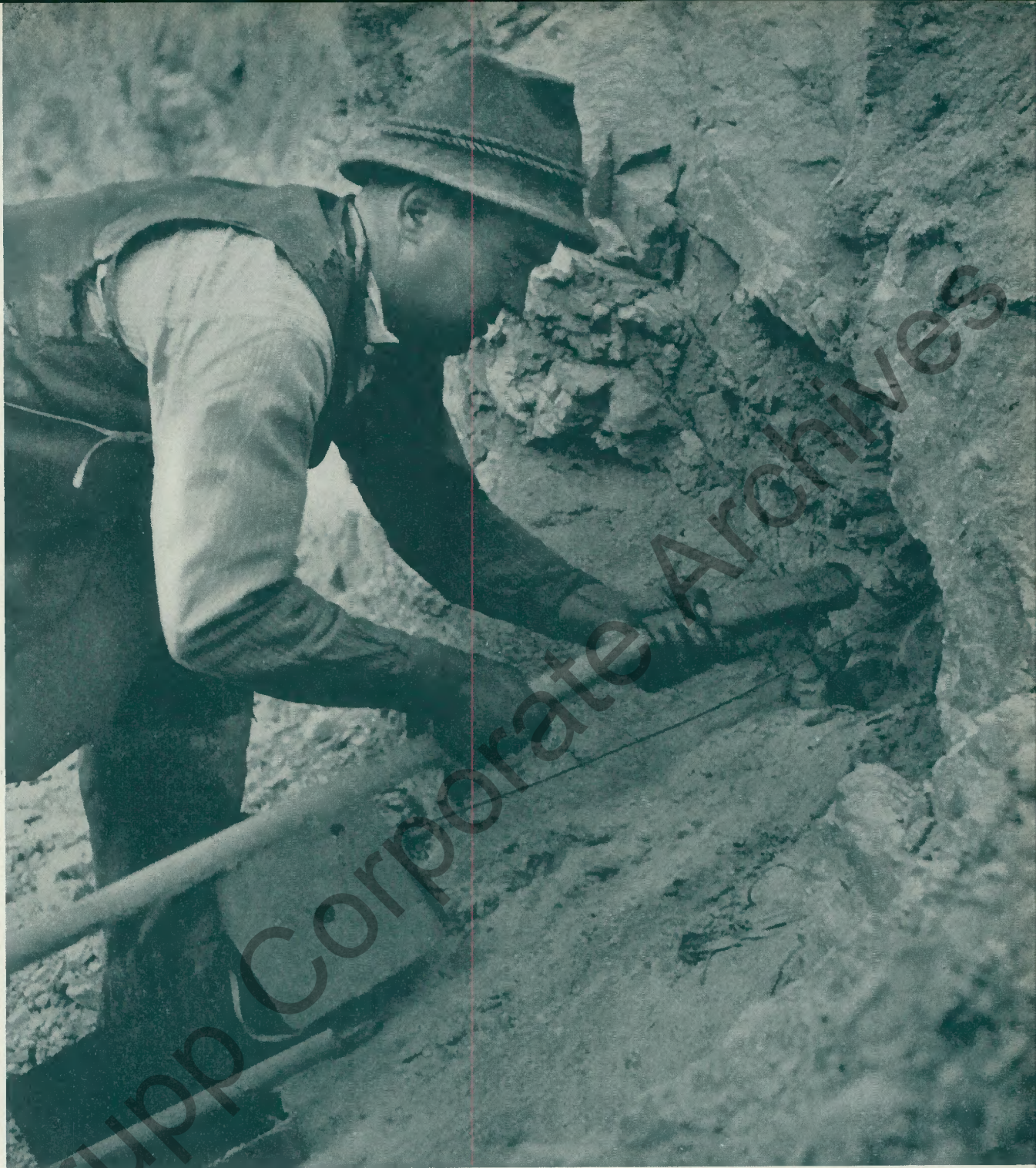
Das Bohrloch wird mit Spreng- stoff besetzt.
