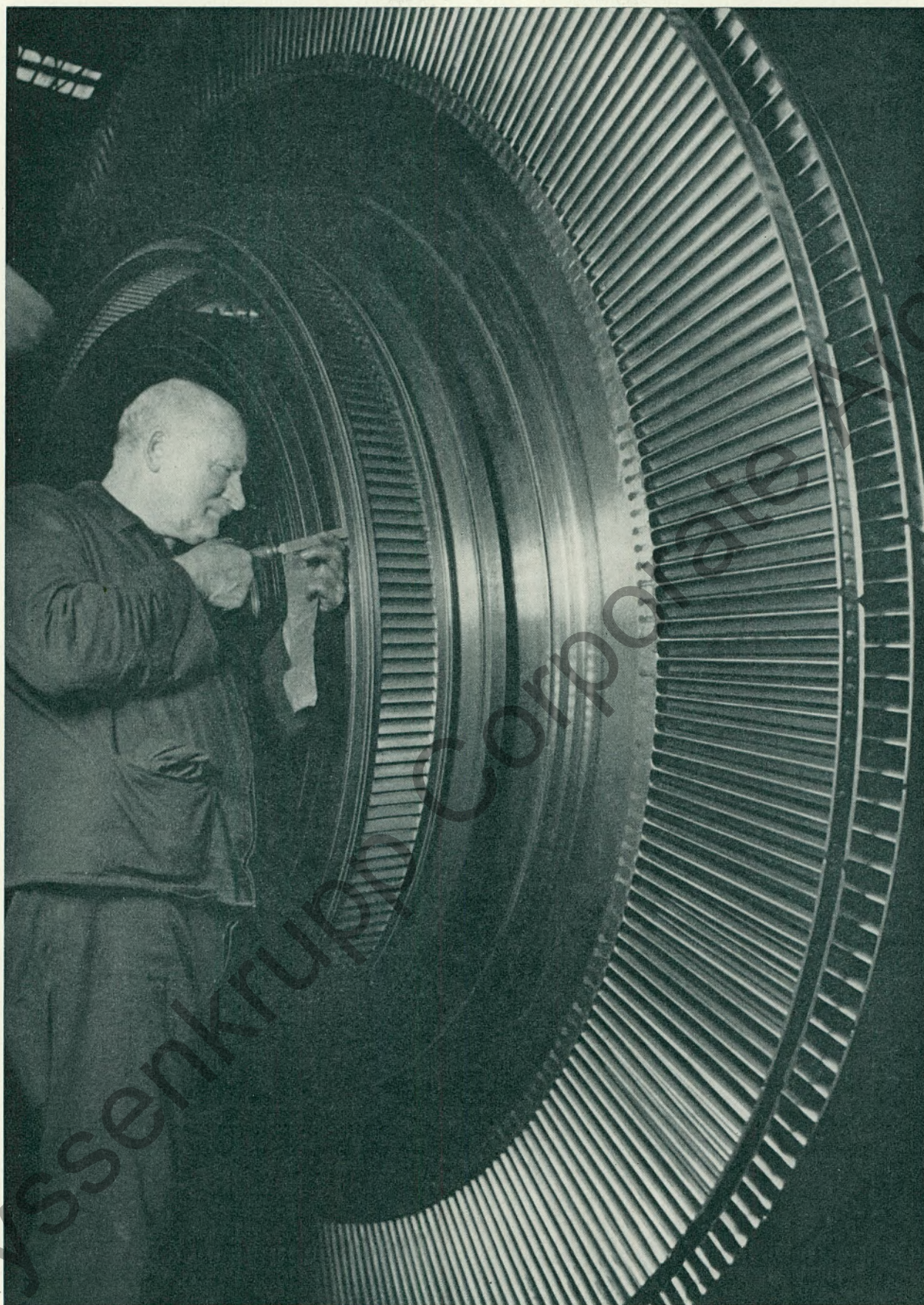
Schaufelrad einer Dampfturbine.
