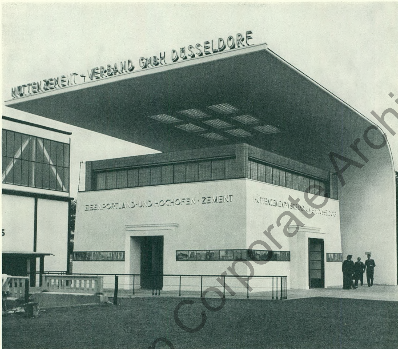
Haus des Hüttenzementverbandes mit freitragendem Schußdach.
