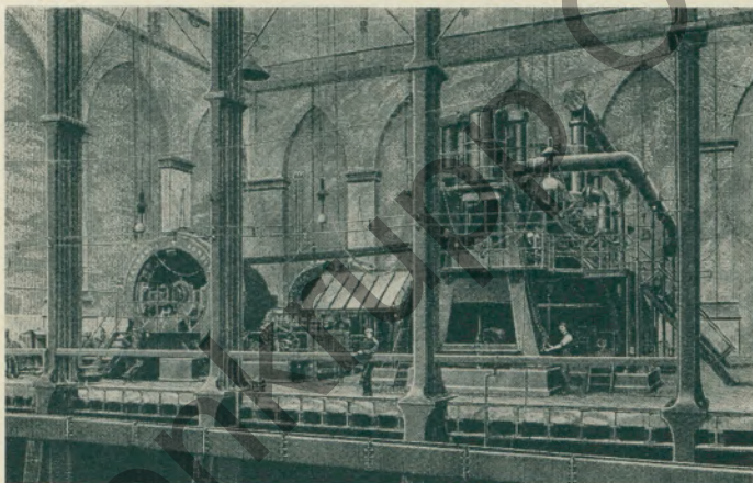
Ältere Ferranti-Maschine im Deptford Kraftwerk.
