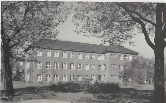
Der Neubau von 1949 von der Ecke Hugo-Schultz- und Saladin-Schmitt-Straße
