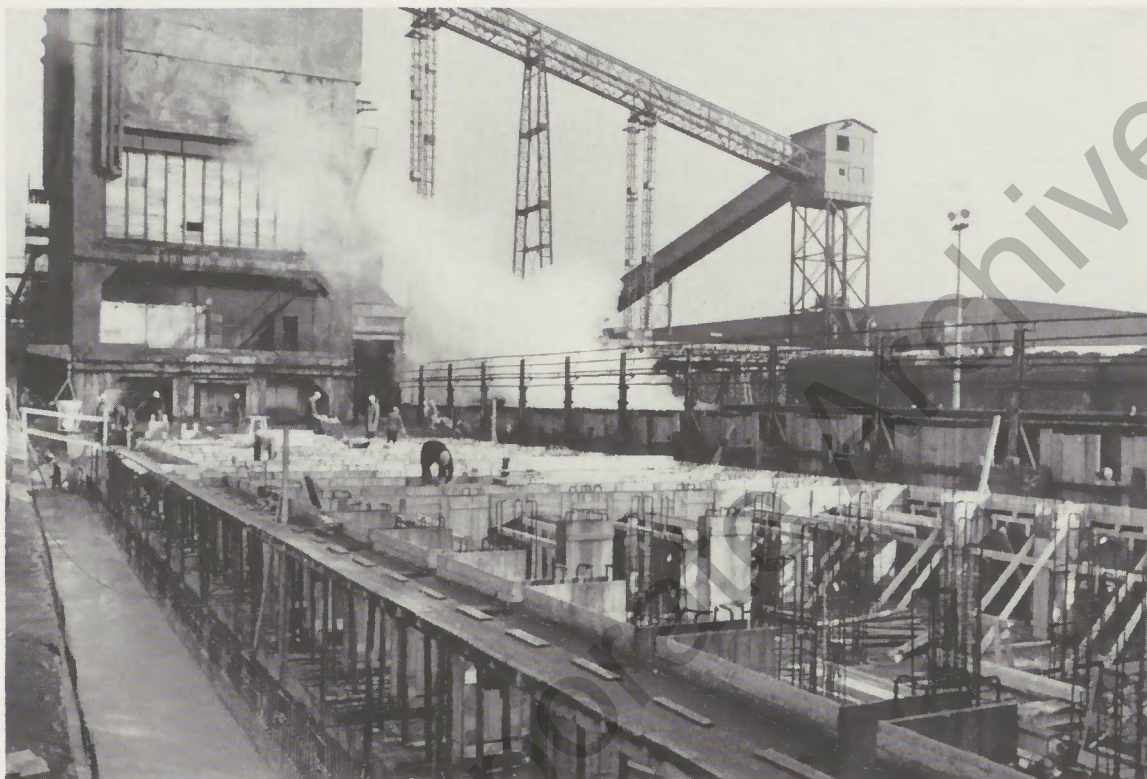
Ein Bild vom Neubau der Batterie II der Zentral-Kokerei Prosper der Rhein Stahl Bergbau A. G. in Bottrop (45 Öfen), über den wir in der April-Ausgabe dieses Jahres bereits berichteten.
