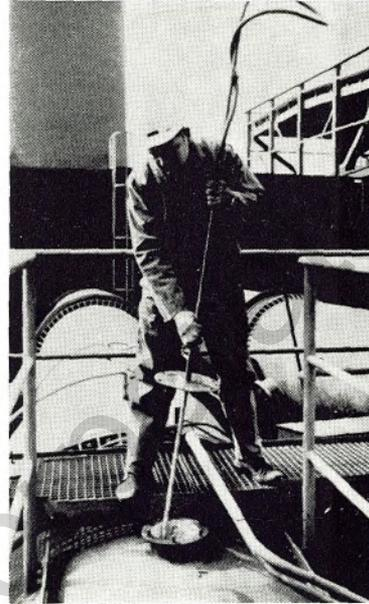
einer Sinteranlage einführt. Es wird hier der Staubgehalt im Reingas ermittelt und festgestellt, ob die garantierten Reingas-Staubgehalte eingehalten werden
