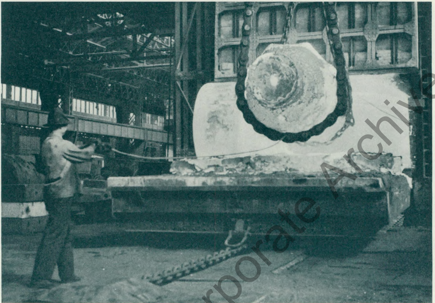
Stahlblock im Vorwärmofen der Witkowiſer Eisenwerke.
