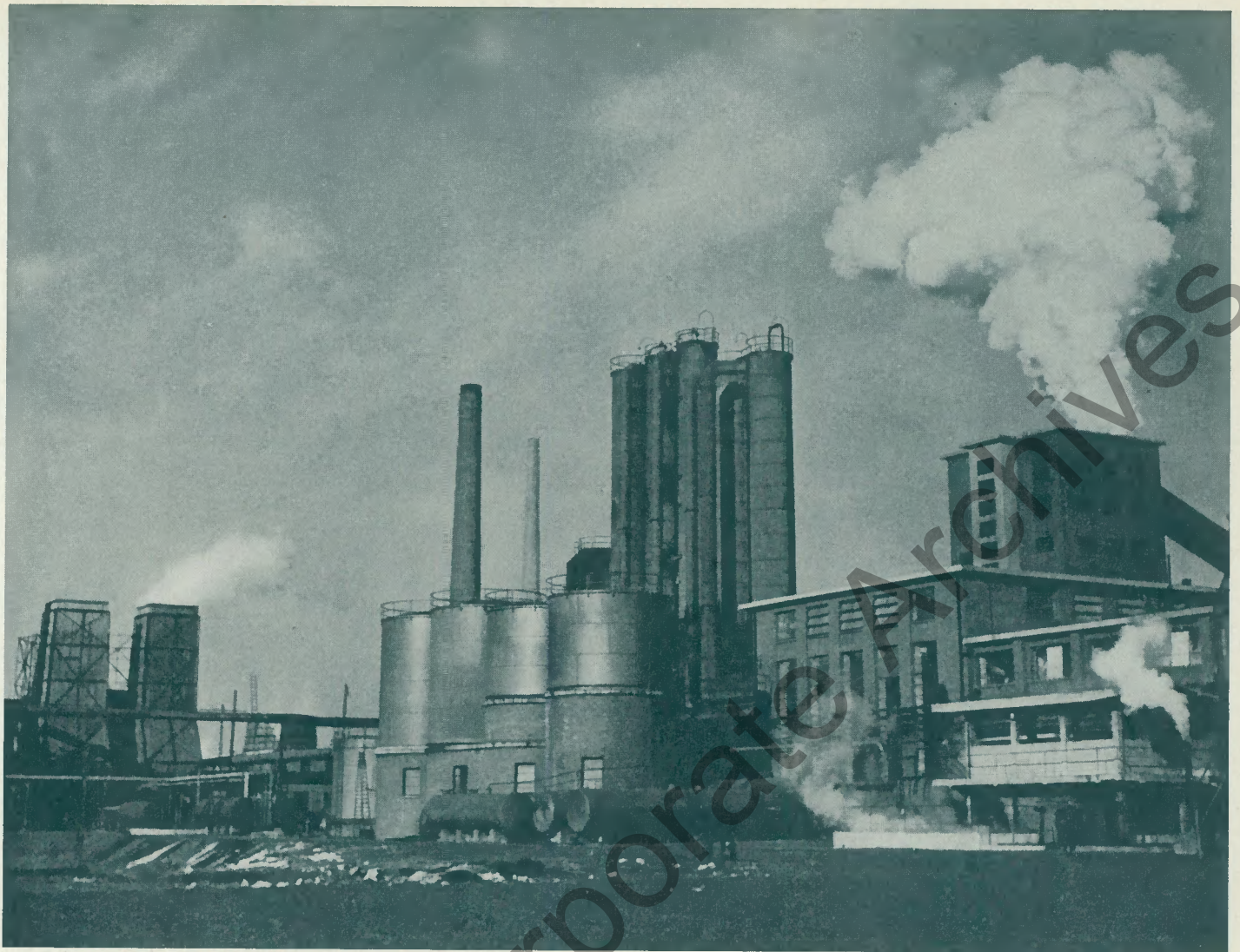
Kokerei der Zeche Erin. Selsenkirchener Bergwerks-AG. — Vereinigte Stahlwerke AG.
