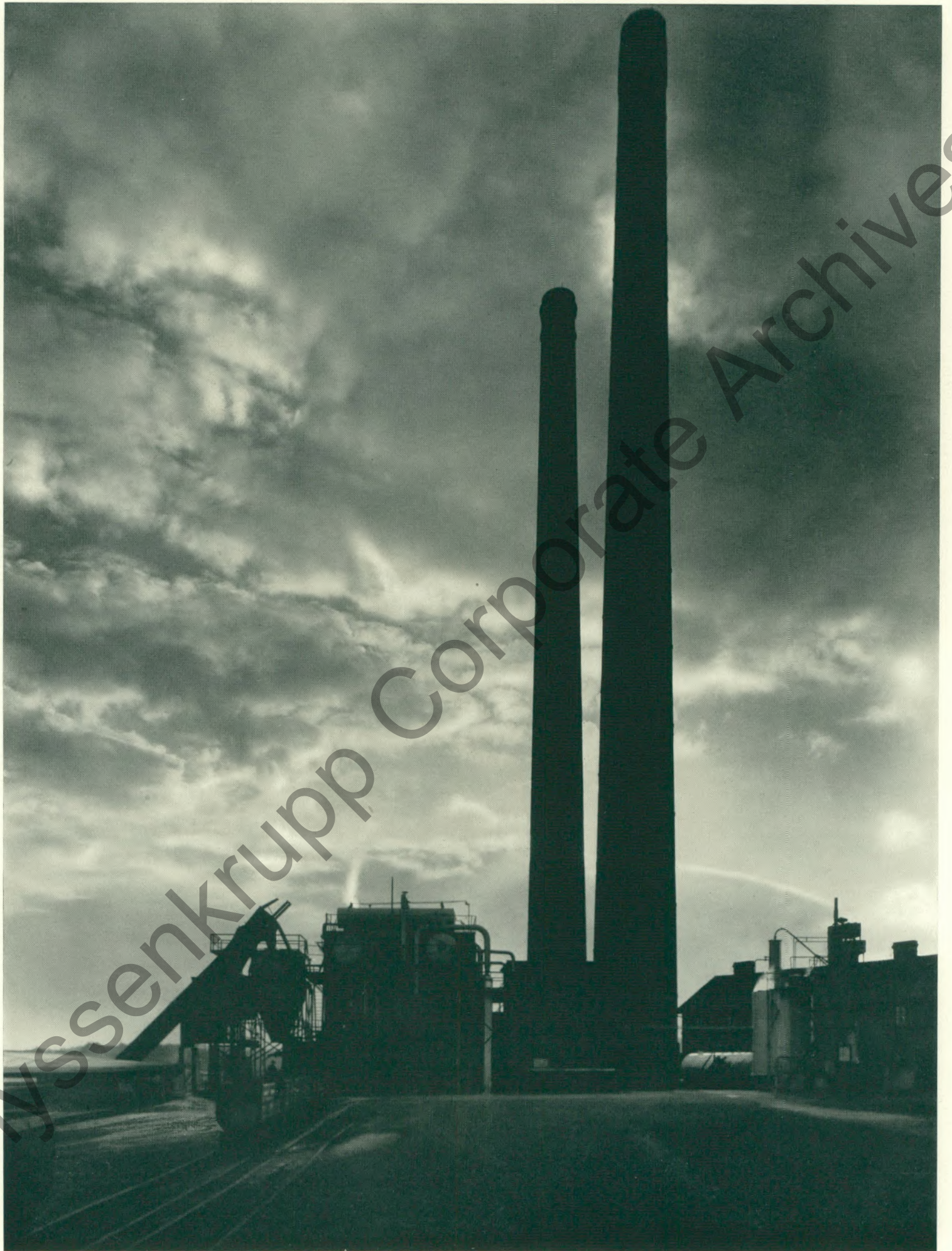
Kesselhaus der Zeche Zollern I. Gelsenkirchener Bergwerks-AG. - Vereinigte Stahlwerke AG.
