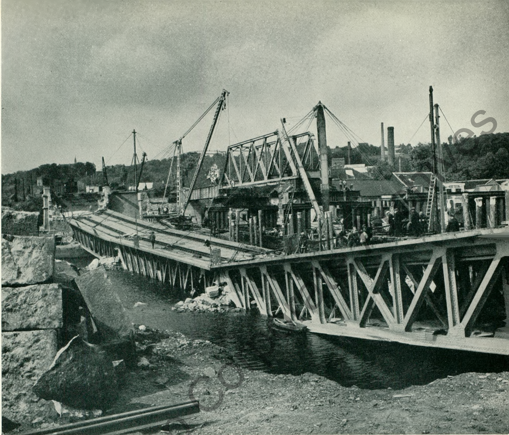
Lichtbild: Dortmunder Union Brückenbau — Hallensleben.
