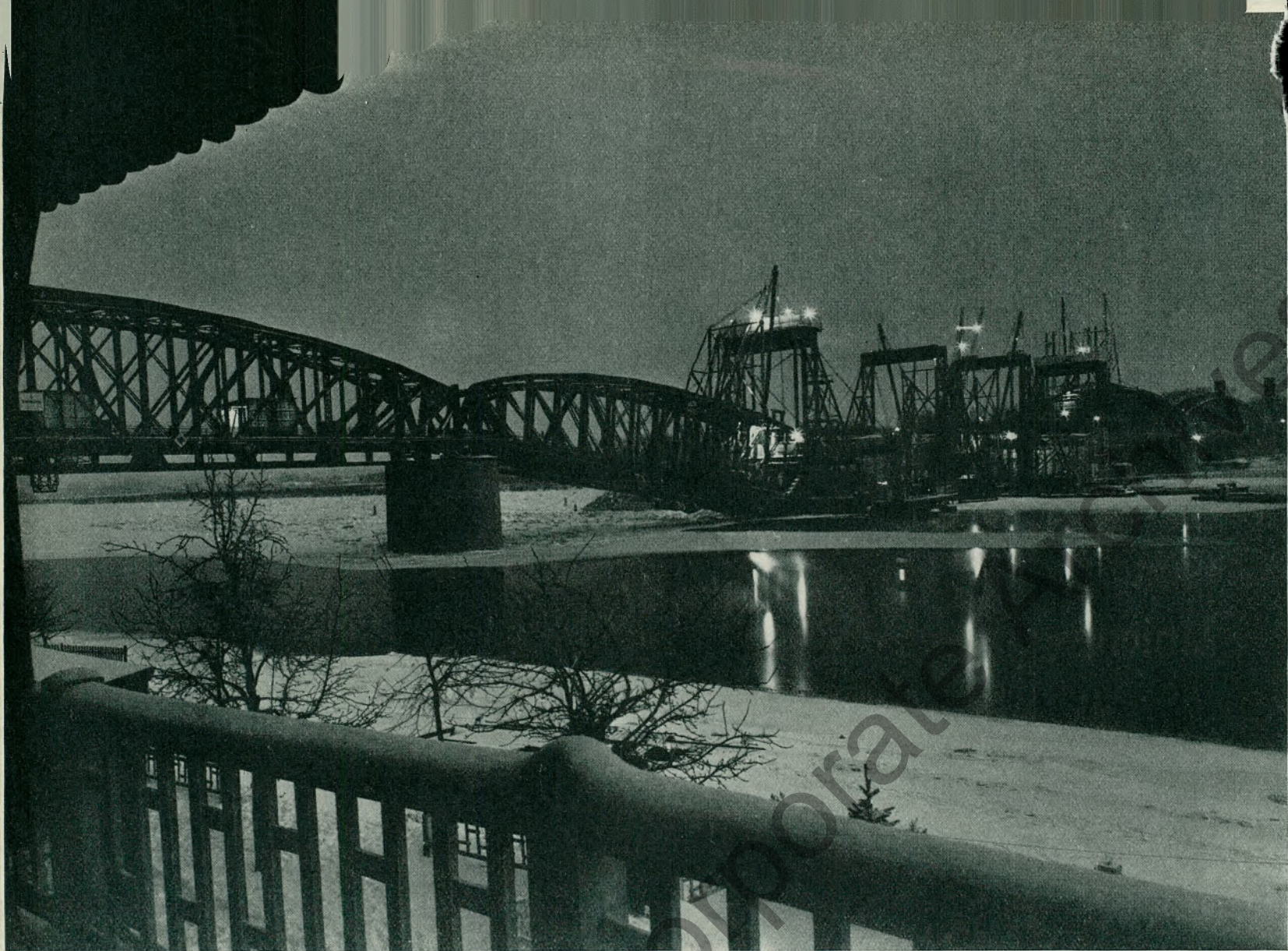
Lichtbild: Dortmund der Union Brückenbau — Hallensleben.
