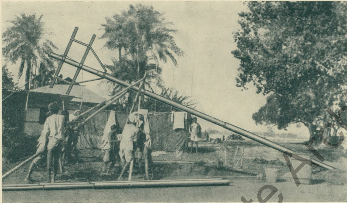
Aufstellung eines von der Deutschen Röhrenwerke A.G. gelieferten Mastes aus nahtlosem Stahlrohr in Assam (Indien).
