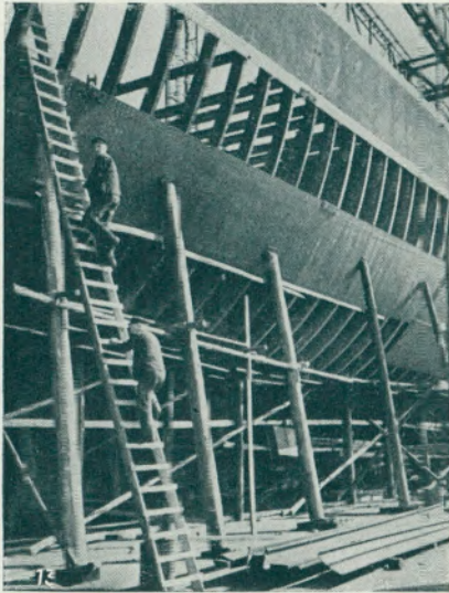
13 Die Spanten werden die einzelnen Platten der Außenhaut aufgenietet. Die übereinanderliegenden Plattenränder werden ebenfalls miteinander vernietet und die Nähte wasserdicht verstemt.
