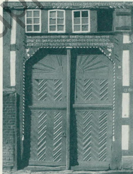
Laustab in seilartiger Form an einem Bauernhaus (1770) in Herrentrop bei Kirchhundem.
