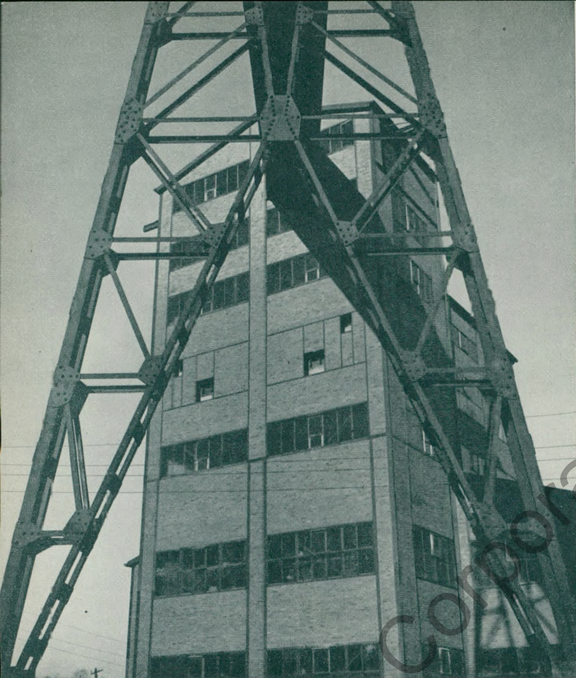
Blick durch die Trägerkonstruktion der Transportbrücke auf die Aufbereitung.
