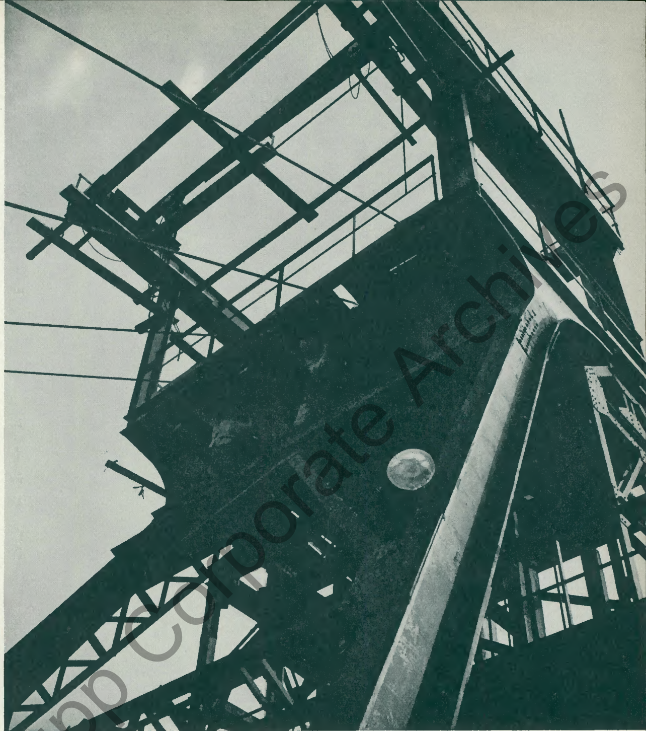
Förderturm auf „Fortuna“.
