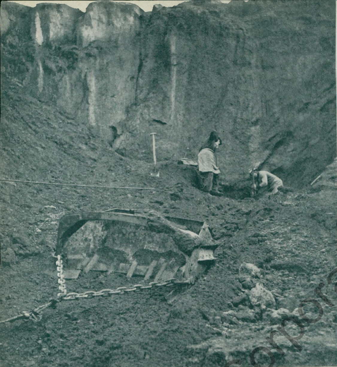
Abraumarbeiten im „Roten Lager Süden“.
