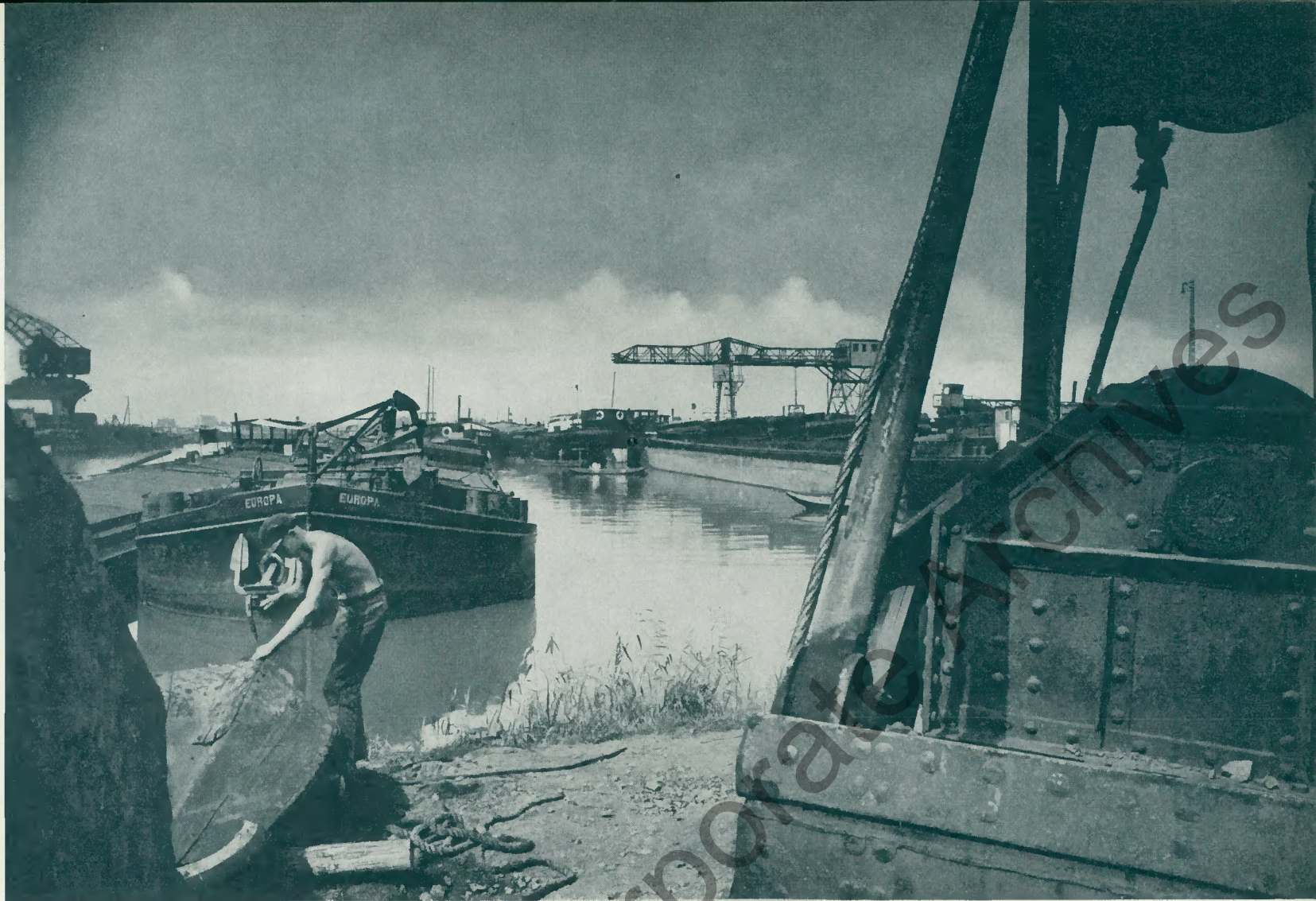
Blick in den Hafen der Zechen Fürst Hardenberg. Selskirkener Bergwerks-AG. - Vereinigte Stahlwerke AG.
