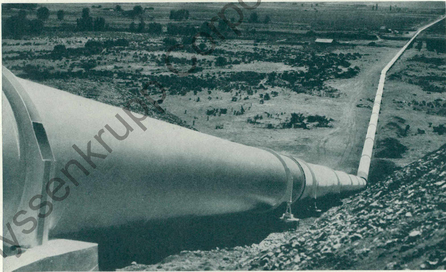
Begehrte Angriffsziele für die gegnerische Luftwaffe bilden auch derartige Erdölferrnleitungen, wie sie z. B. England in Vorderasien in einer Länge von Hunderten von Kilometern errichtet hat.
